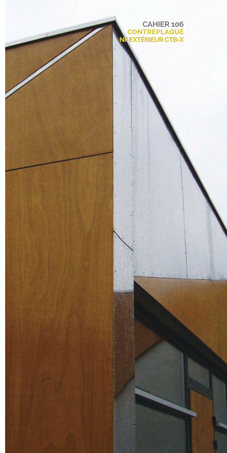
Figure 34 : Traitement des joints horizontaux entre panneaux
